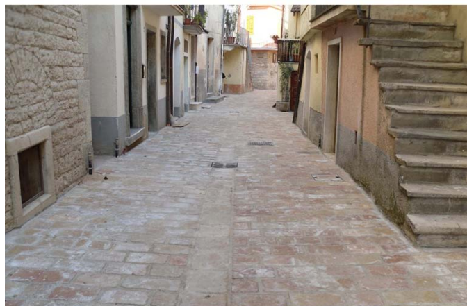
Via Piazza vecchia - dopo l’intervento
