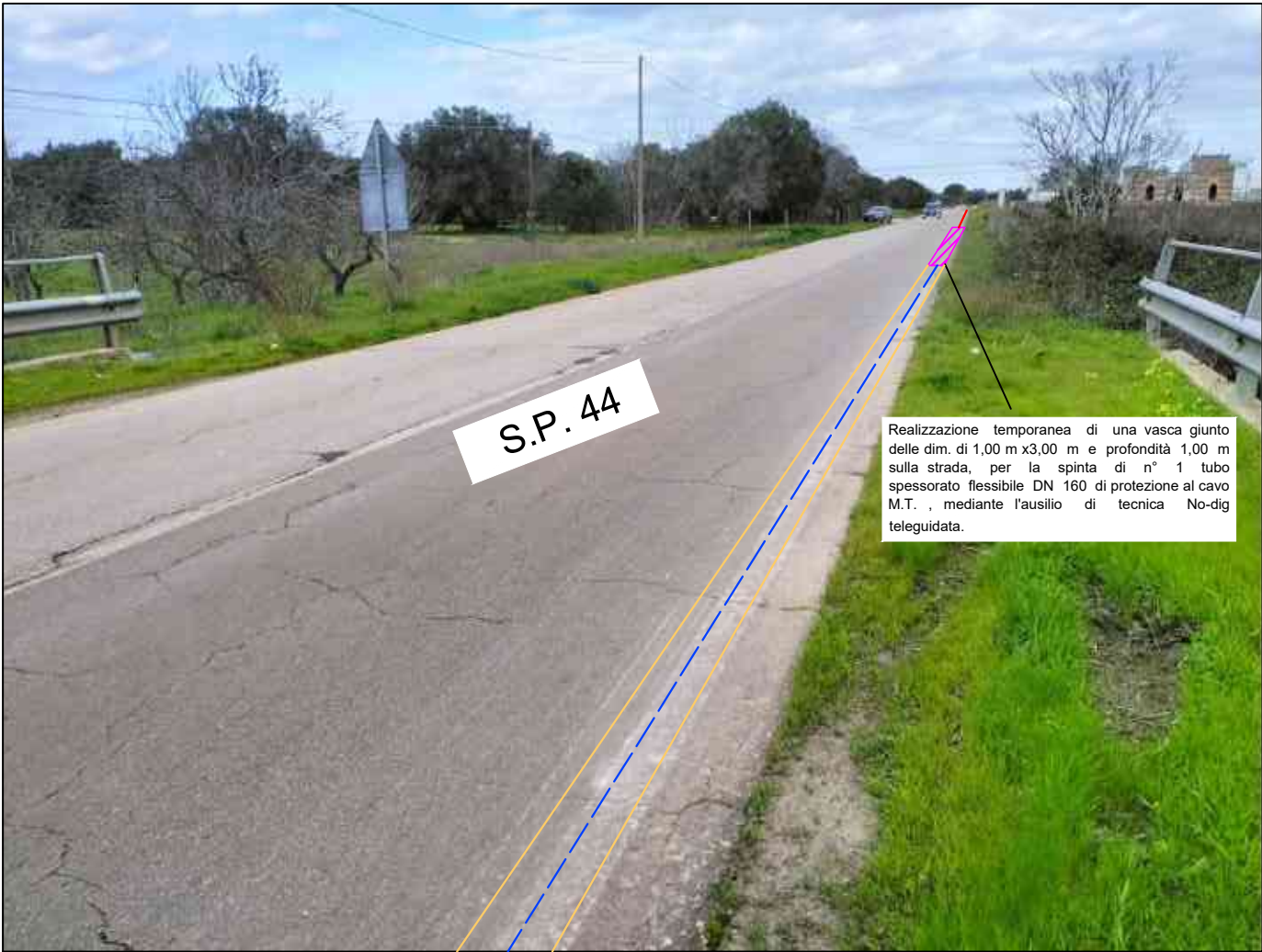
Nuova linea interrata in cavo MT AL 185 mmq da posare con tecnica No-dig teleguidata. Attraversamento trasversale al canale di raccolta dell'acqua.
