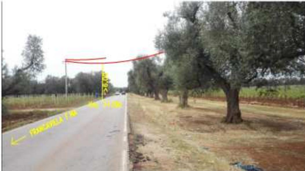
Foto 5- individuazione del sostegno da sostituire e della linea aerea BT a farsi
