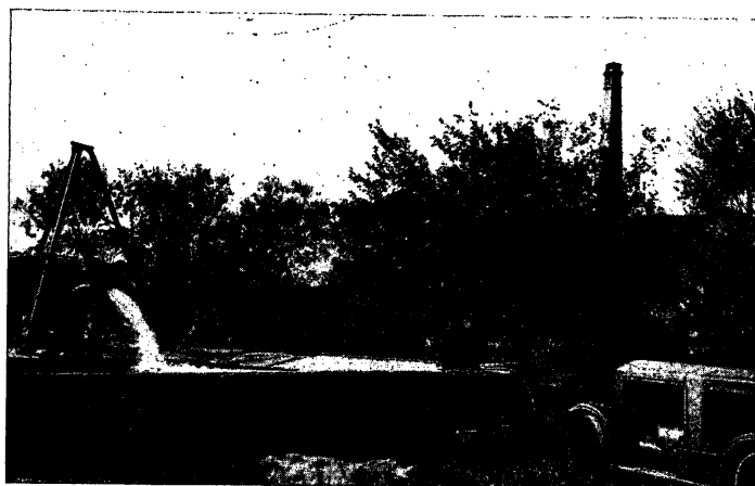
Prova di portata del pozzo Ranieri, Bari.
