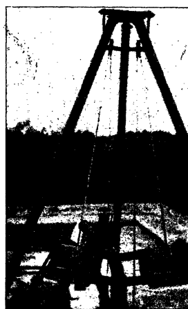
Prova di portata dei pozzi. Particolare attrezzatura.
