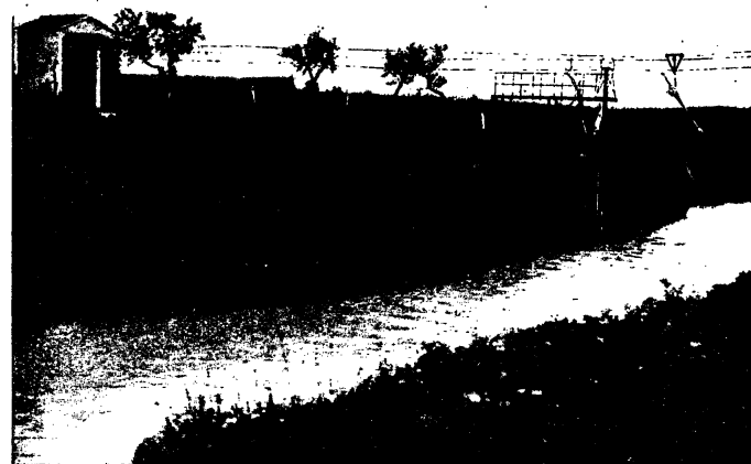
Stazione idrometrografica sul Cervaro ad Inconronata.
