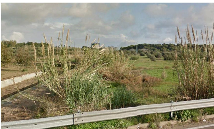
Alveo cementificato ed aree con vegetazione rada
