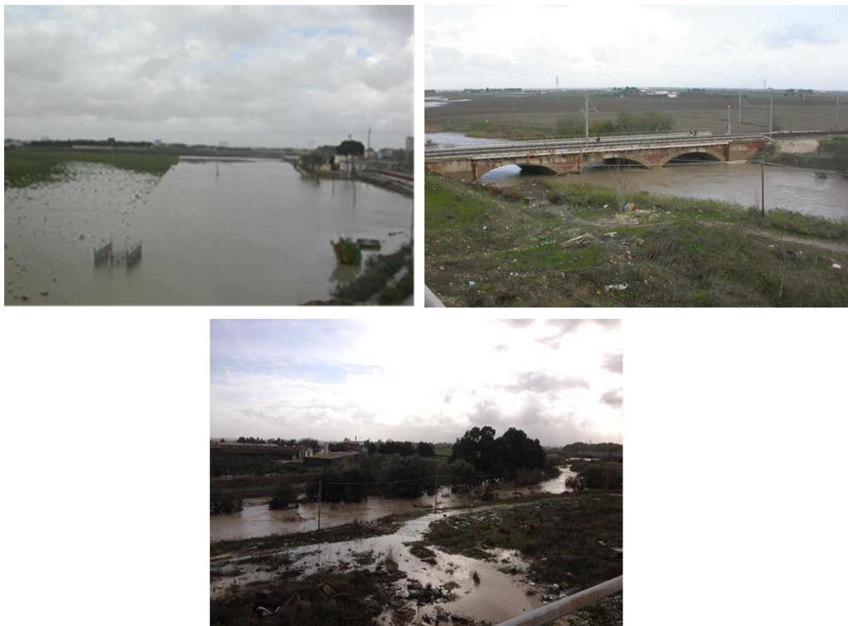
Figura 1.19 - Vista degli allagamenti in zona A.S.I.
