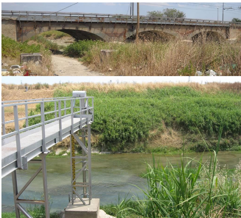
Figura 1.10 – Vista del ponte ad Incoronata (sopra) e della stazione di misura idrometrica (sotto) immediatamente a valle del ponte
